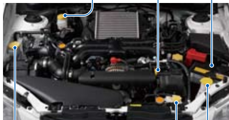
パワーステアリングフルードリザーバータンク 冷却水リザーバータンク ウィンドウウォッシャータンク
